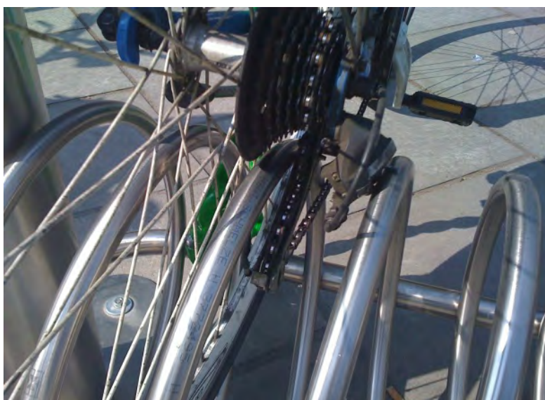
Foto 2 – Esempio di sostegno inadeguato
